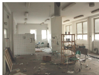
Takhle neútěšně vypadá budoucí výtvarka dnes.
